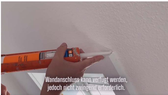
2. Wandanschlüsse können mit Acryl verfugt werden. Bei Holzdecken wird keine Verfugung empfohlen.
