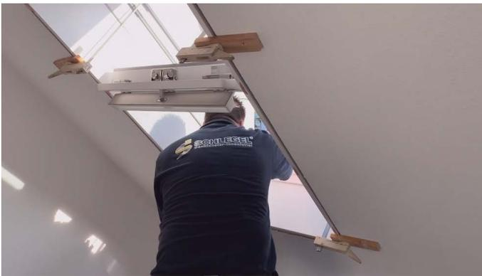
2. Den Futterkasten mit 4 Stück Montagezwingen am Dachfenster fixieren. Die vordere Kante muss bündig zur Decke sein.
