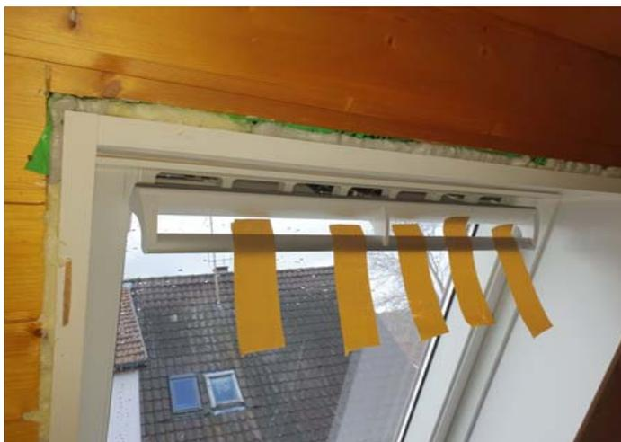
Der Futterkasten ist an den Befestigungspunkten mit 2K Schaum (gelber Schaum) fest im Dach eingebaut.
