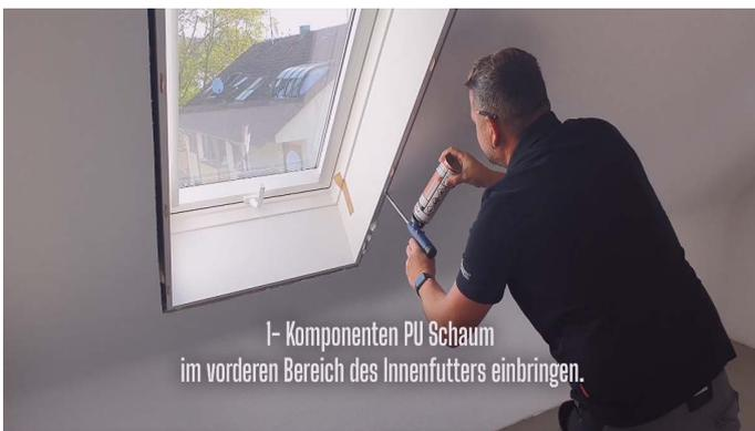
3. Im Vorderen Bereich des Futterkastens 1K PU Schaum einbringen. Auf die Dosierung achten, der Schaum drückt bis zu 12 Stunden nach!
