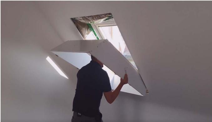
1. Den Futterkasten in das gedämmte Dachfenster bis zum Anschlag in die vorgesehene Nut am Dachfensterrahmen einsetzen.
