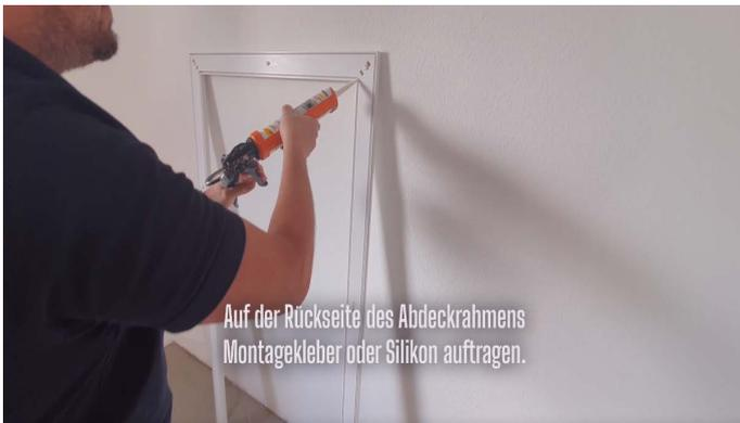
2. Auf der Rückseite des Abdeckrahmens Montagekleber oder Silikon auftragen. Die Verklebung bei den inneren Nuten durchgehend und an den Flächen punktiert anbringen. Der Rahmen wird auf die Lamello-Verbinder am Innenfutter aufgesteckt und verklebt.
