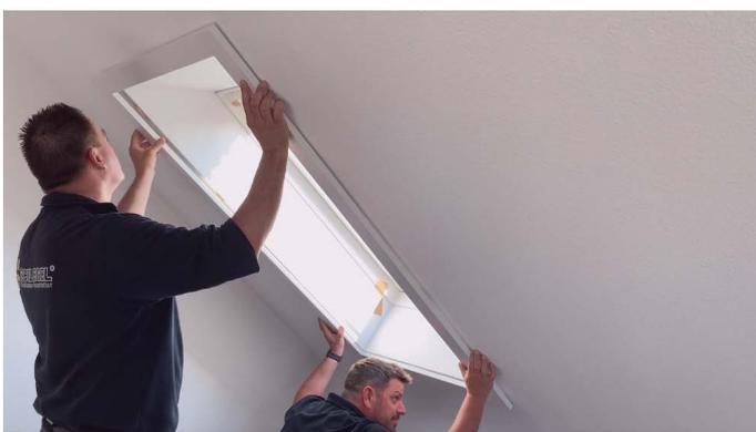
4. Den Abdeckrahmen auf den Futterkasten setzen und mit Klebebändern sichern. Der Rahmen kann auch rückseitig mit Doppelklebeband an der Decke fixiert werden.
