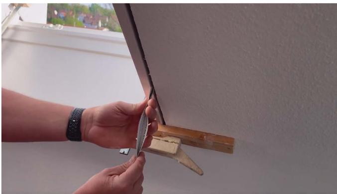
3. An allen 4 Schaum Setzpunkten Papierstreifen oder z.B. Zeitungstreifen einbringen. Dadurch wird der Schaum verteilt und tropft nicht auf den Boden.
