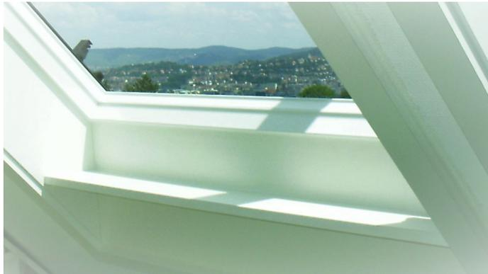
1. Simsen werden erst nach dem Einbau des Innenfutters montiert.
