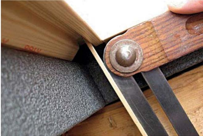
Winkelschmiege oder anderes Messwerkzeug an unteren Ecke anlegen. Den Meterstab am Winkel anlegen um die Materialstärke zu simulieren.
