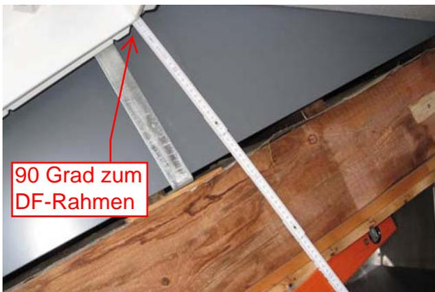
Den Meterstab oben ab Eck der Dachfenster-Nut **90 Grad zum Dachfensterrahmen** anlegen, dann das Maß inkl. Nuttiefe bis zur Vorderkante der Zimmerdecke messen.
