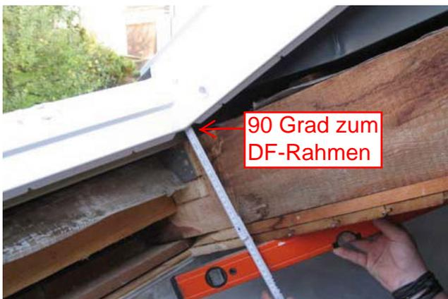
Den Meterstab unten ab Eck der Dachfenster-Nut **90 Grad zum Dachfensterrahmen** anlegen, dann das Maß inkl. Nuttiefe bis zur Vorderkante der Zimmerdecke messen.
