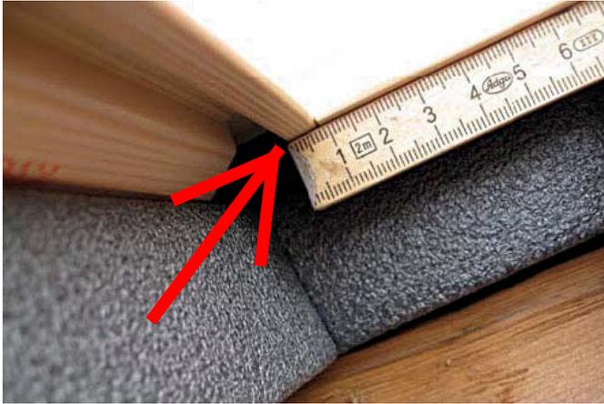
Den Meterstab an der Innenkante der Dachfenster-Nutwange anlegen.
