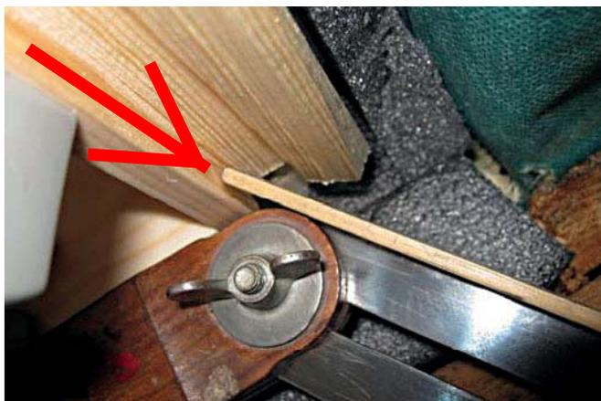
Den Meterstab etwas in die Nut nach innen versetzt auf die Schmiege auflegen um den Futtereinstand zu simulieren, dann den Winkel abnehmen.
