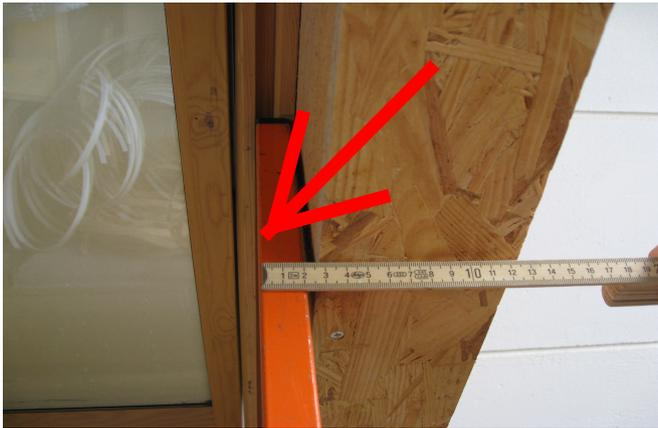
Wasserwaage oder einen Winkelmesser im 90 Grad Winkel zum Dachfenster an die Innenkante der Rahmen-Nut anlegen.
