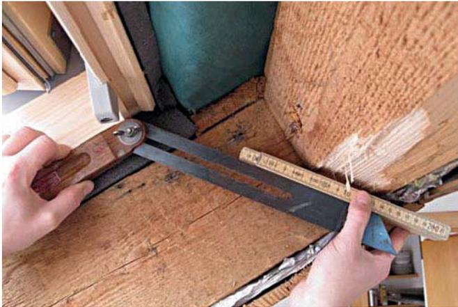
Winkelschmiege oder anderes Messwerkzeug an oberer Ecke anlegen. Den Meterstab auf den Winkel auflegen um die Materialstärke zu simulieren. Den Winkel soweit hochziehen, dass der Abdeckrahmen ausreichend abdeckt.
