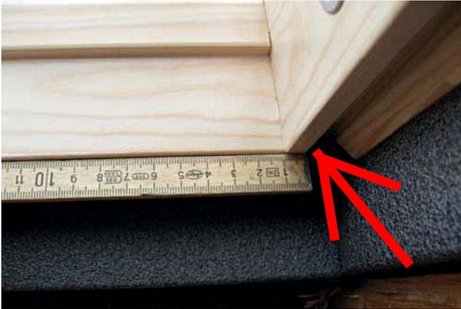
Den Meterstab wie vor an der Innenkante der Dachfenster-Nutwange anlegen.
