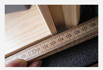
Den Meterstab (Zollstock) an der Innenkante der Dachfenster-Nutwange (Bild 1) anlegen, dann die lichte Länge (Bild 2) bis Innenkante der gegenüberliegenden Seite (Bild 3) messen.
