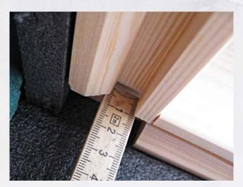
Die Futtertiefe an allen Ecken des Innenfutters messen. Bei Maßdifferenzen (durchhängende Decken) möglichst das Maß vermitteln, notfalls außen mehr Überstand rechnen und nach der Montage den Bekleidungsrahmen auf der Deckenseite (außen) mit Acryl oder Silikon in passender Farbe abfugen.
