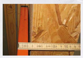
Wasserwaage im 90 Gradwinkel zum Fenster an der lichten Innenkante der Nut anlegen und mit Meterstab ab Vorderkante der Wasserwaage die Bekleidungsbreite ermitteln. Standardbreiten 65, 80 und 100 mm!
